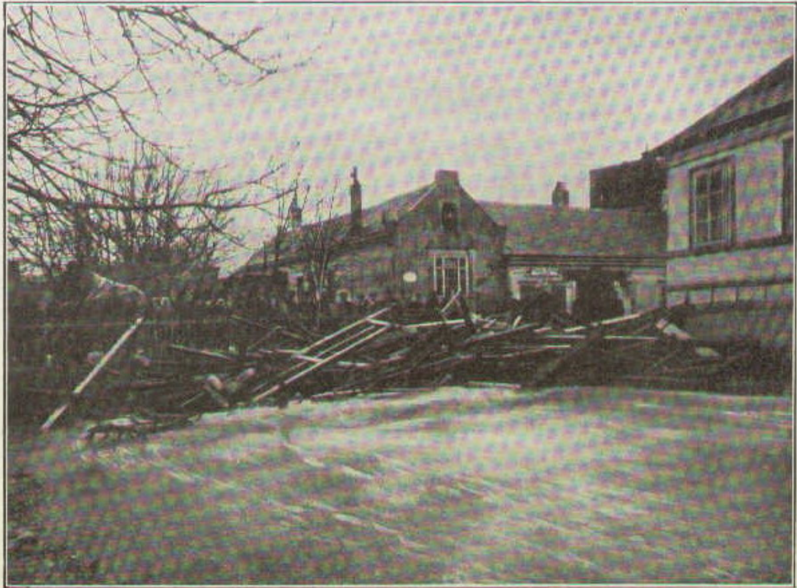
Hochwasser und Stauung an der Neufelder Brücke am 4. April 1900
