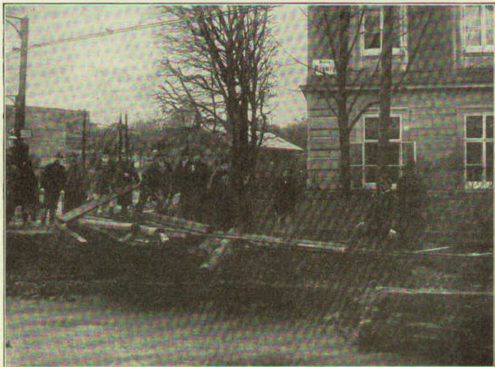
Sicherungsarbeiten bei der Hochwasserkatastrophe am 4. April 1900
