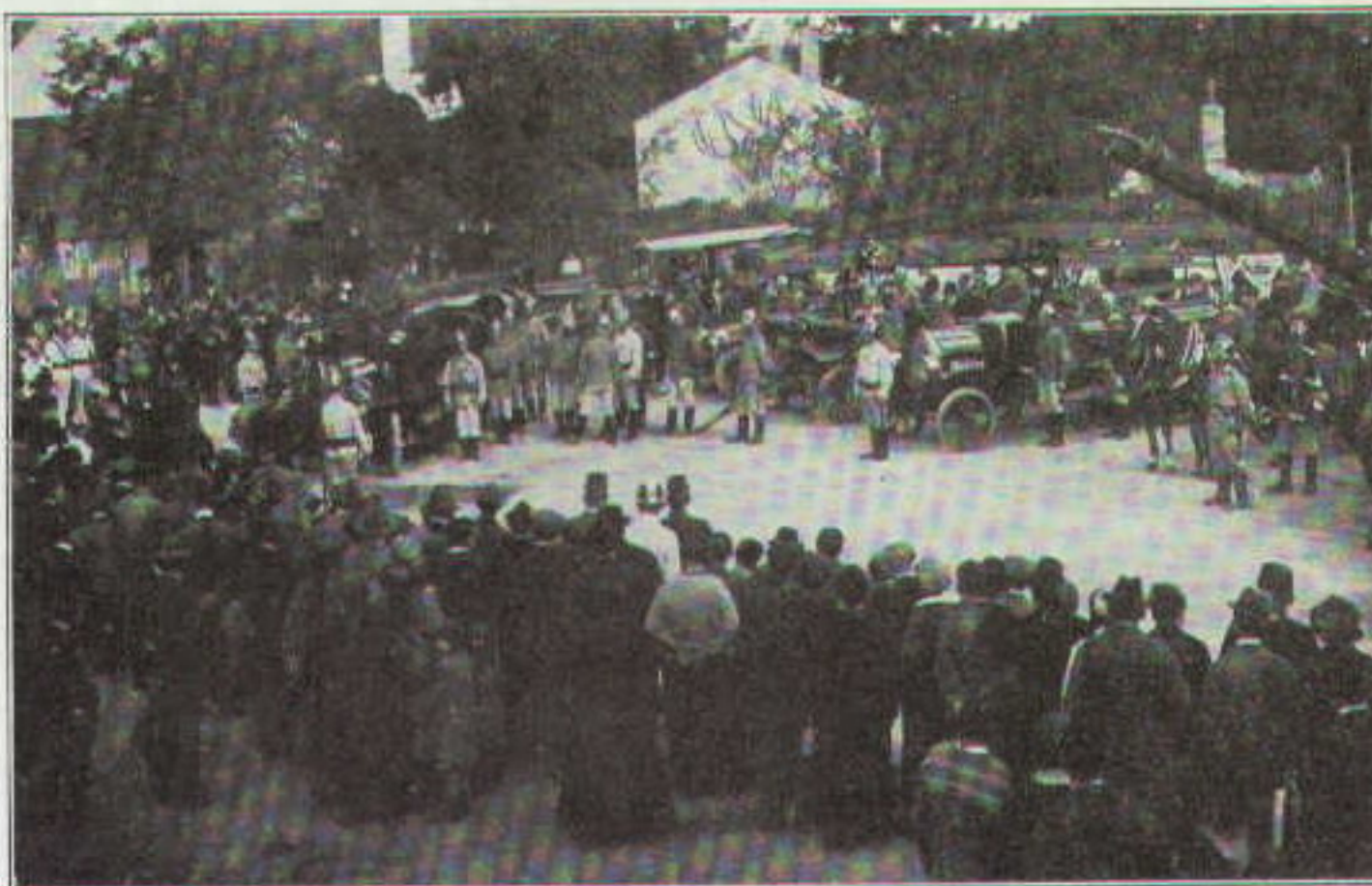
Übernahme einer neuen Autolöschmaschine
