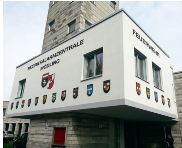
Fertigstellung und Eröffnung der neu errichteten und ausgestatteten Alarmzentrale, in der nun auch der Notruf NÖ 144 der Rettung untergebracht ist.
