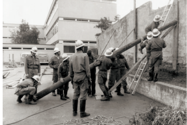
Pölarbeiten einer vom Einsturz bedrohten Stützmauer bei der Europaschule
