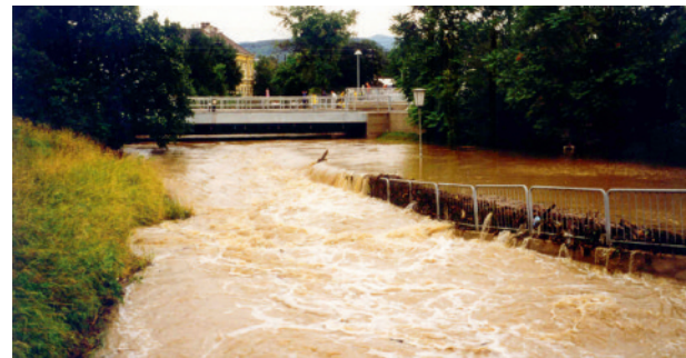
Hochwasser Mödlingbach beim Bahnhof
