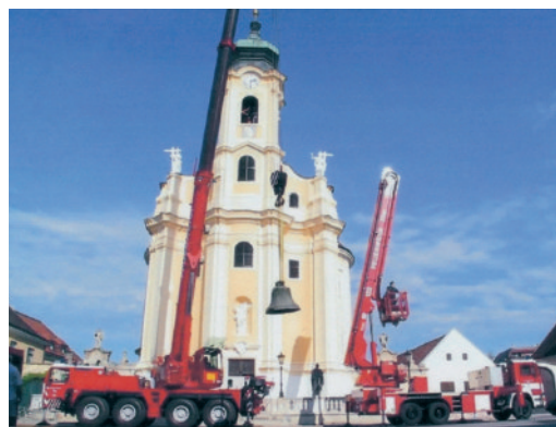
Kran- und Hubsteiger-einsatz der anderen Art – hier bei der Montage von Glocken der Pfarrkirche Laxenburg
