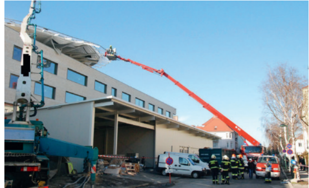
Einsturz der in Bau befindlichen Hubschrauberplattform beim Krankenhaus Mödling, mehrere verletzte Arbeiter und großer Sachschaden, erster Großeinsatz der mit Jahresbeginn 2014 gegründeten BTF Landeskrankenhaus Mödling
