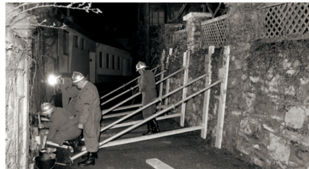
Hangrutsch bei der St. Othmar-Kirche, eine Stützmauer muss gepölzt werden.
