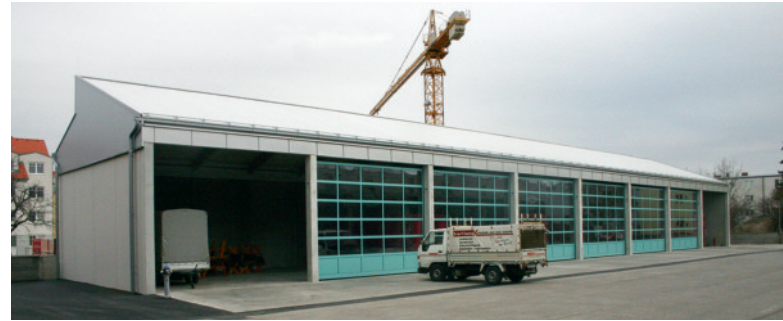
Errichtung der als Garage und Katastrophenschutzlager dienenden Halle
