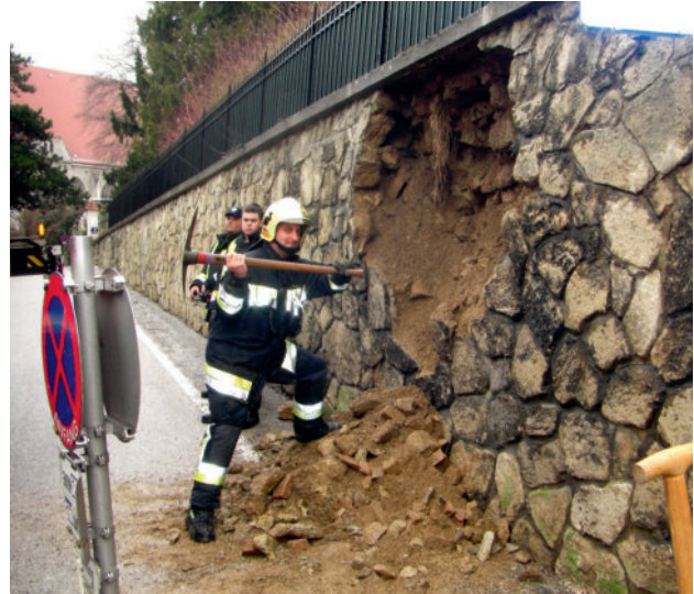
Pölung einer abgerutschten Stützmauer in der Kowatschitschgasse
