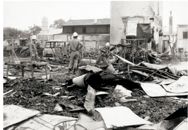
Großbrand beim Holzhandel und Heimwerkermarkt Hauptmann
