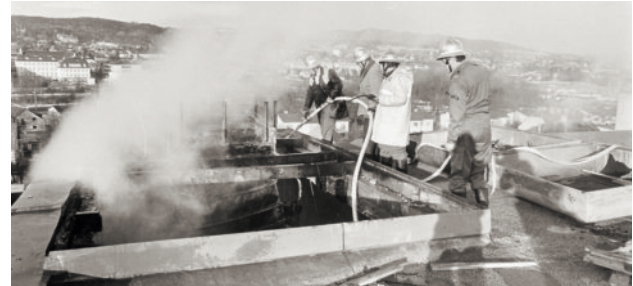
Brand auf dem Dach des Kinderturmes des Krankenhauses Mödling
