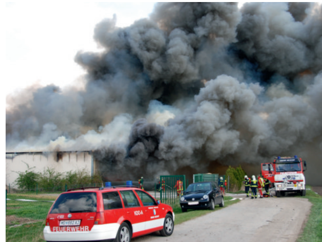
Totalbrand einer Lagerhalle in Wr. Neudorf
