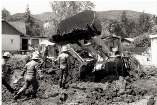
Bergung eines eingesunkenen Baggers auf einer Baustelle
