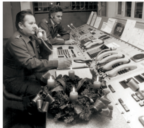
Das Herzstück des neuen Feuerwehrhauses: die moderne Einsatzzentrale
