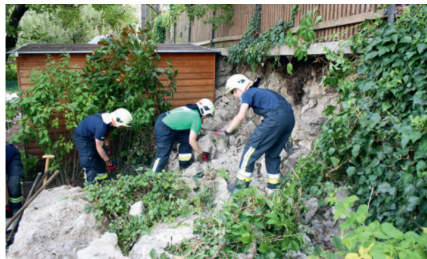
Fels- und Steinsturz bei der Othmarkirche erfordern wieder einmal Pölzarbeiten.
