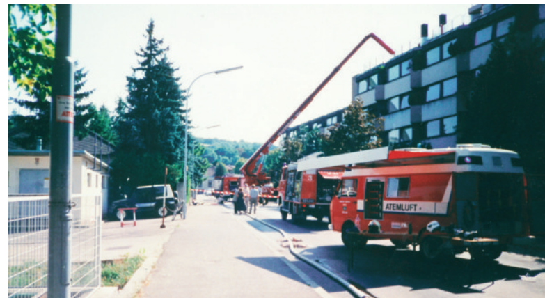
Fassadenbrand der „Kupferbauten“ in der Weißes Kreuz-Gasse
