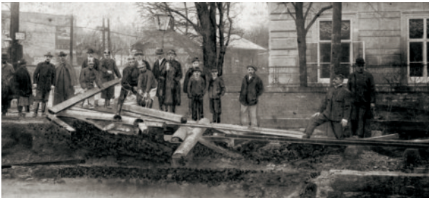
Heftige Unwetter mit Hochwasser in Mödling, die Aufnahme zeigt den zerstörten Gleiskörper der Hinterbrühler elektrischen Bahn beim Neuweg.
