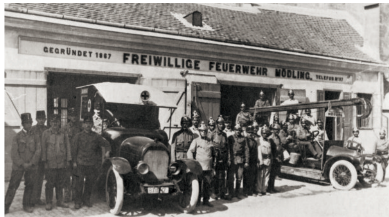
Remisengebäude in der Elisabethstraße, vor dem Umbau noch eingeschößig, mit Löschfahrzeug Austro-Daimler und Rettungswagen
