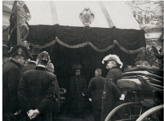
Eröffnung der neuen Mödliner Wasserleitung mit Hydrantennetz durch Kaiser Franz Joseph im Priebrnitztal
