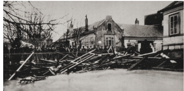
Hochwasser im Bereich der Mödlingbachbrücke in der Neusiedlerstraße
