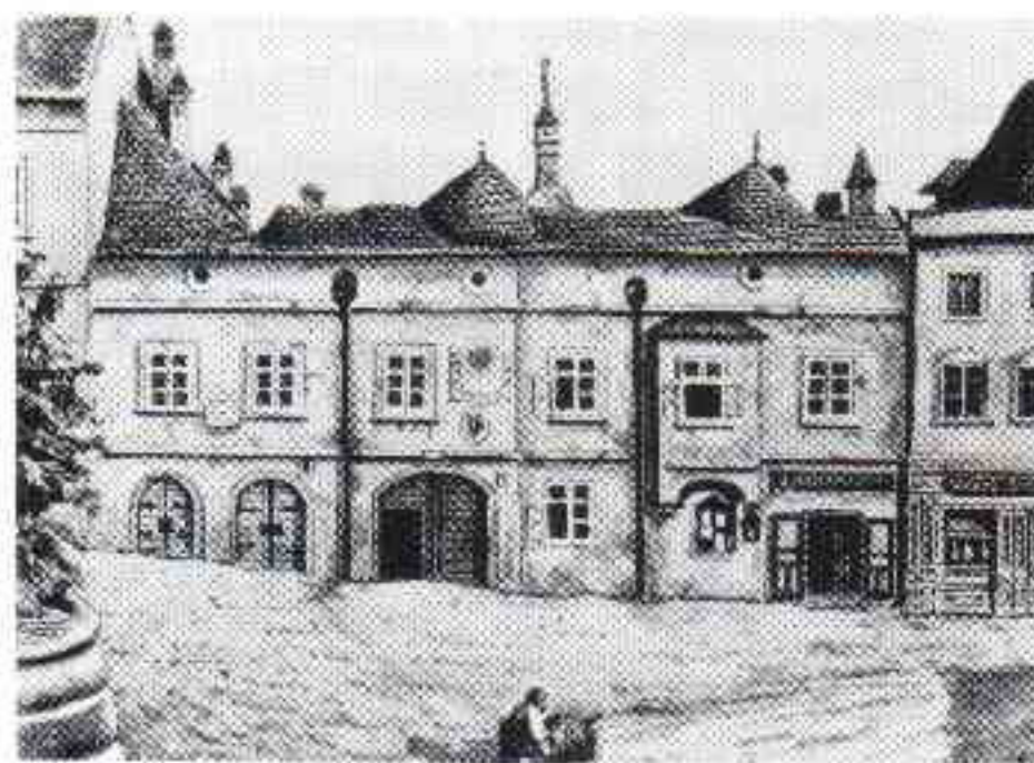
Im Hause Schrankenplatz 3, (heute Posthof) waren 1867 die Feuerwehrgeräte untergebracht.
